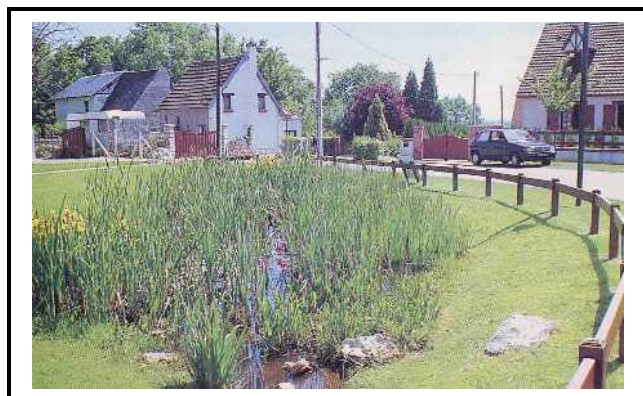
Noue engazonnée Opération Belbeuf – 76 Source Foncier Conseil
