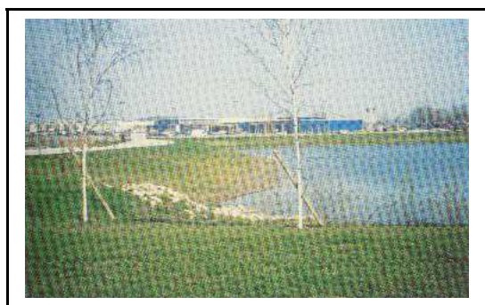
Bassin en eau du parc technologique de Saint-Priest Porte des Alpes Source CERTU
