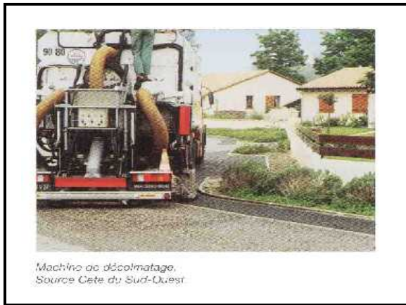
Machine de décolmatage Source CETE du Sud-Ouest
